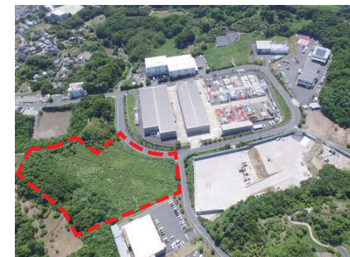
写真上/分譲中の区画G-4(赤点線囲み部分)を西側から望む
